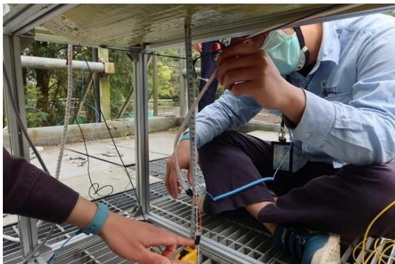
圖 17. 架設雷管
